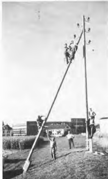
Hochspannung Freileitungsbau 16 000 Volt
