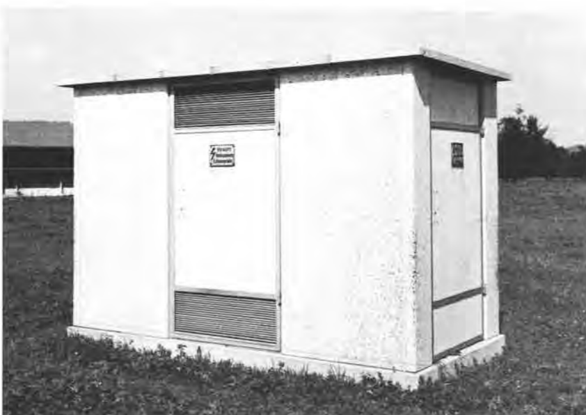
Transformatoren-Station Oberhofenstrasse aus Bauelementen
