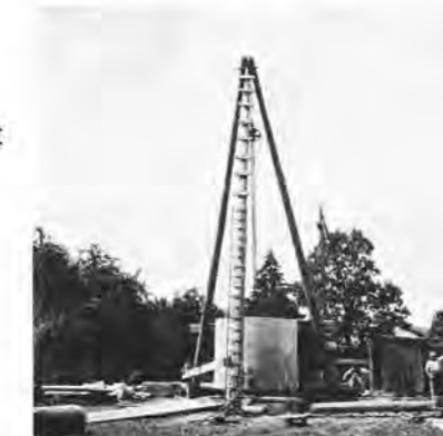
Der neue Brunnenschacht
