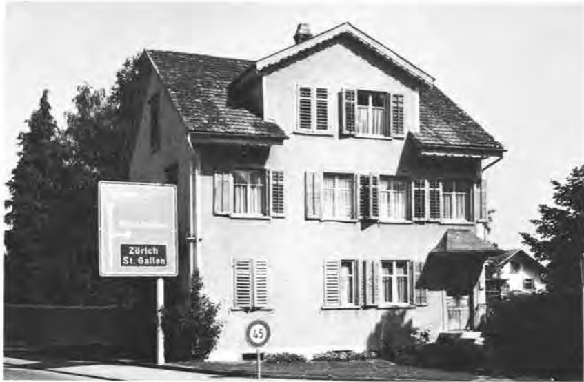
Wohnhaus Schurter Winterthurerstrasse 16 2 Wohnungen
