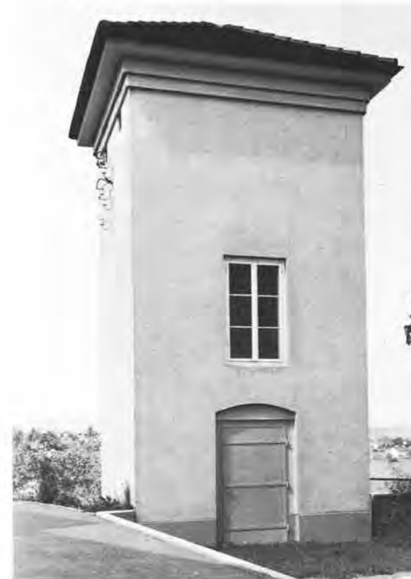
Transformatoren-Station Obermatt ausgebaut für Hoch- und Niederspannungs-Kabelanlage 2 Transformatoren
