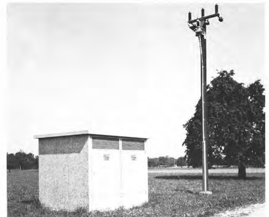
Hochspannungs- Verteilkabine 16 000 Volt Grünau
