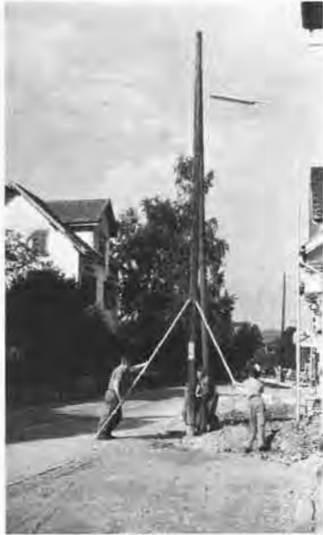
Abbruch der Freileitungen
