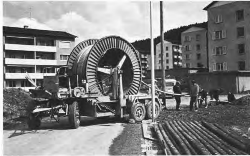
Hochspannung Kabelzug-Verlegung in PVC-Rohre (Kunststoff)
